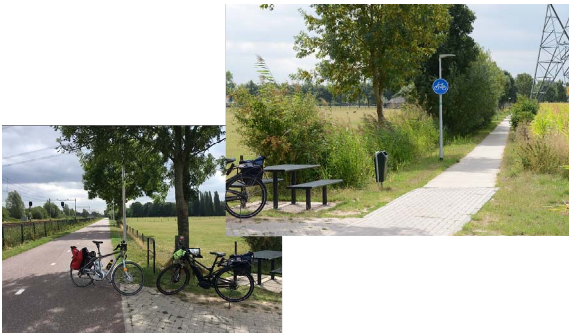
Abbildung 32: Hochwertige Ausstattung Radwege, Belag, Beleuchtung, Aufenthalt
