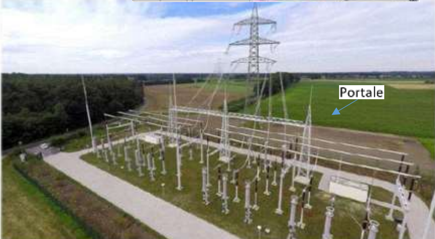
Beispiel KÜS für Wechsel Freileitung auf Erdkabel (hier ohne Drossel, Betriebsgebäude und Lager)
