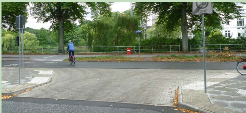
Abbildung 29: Gehwegüberfahrt am Leinpfad in Hamburg.
