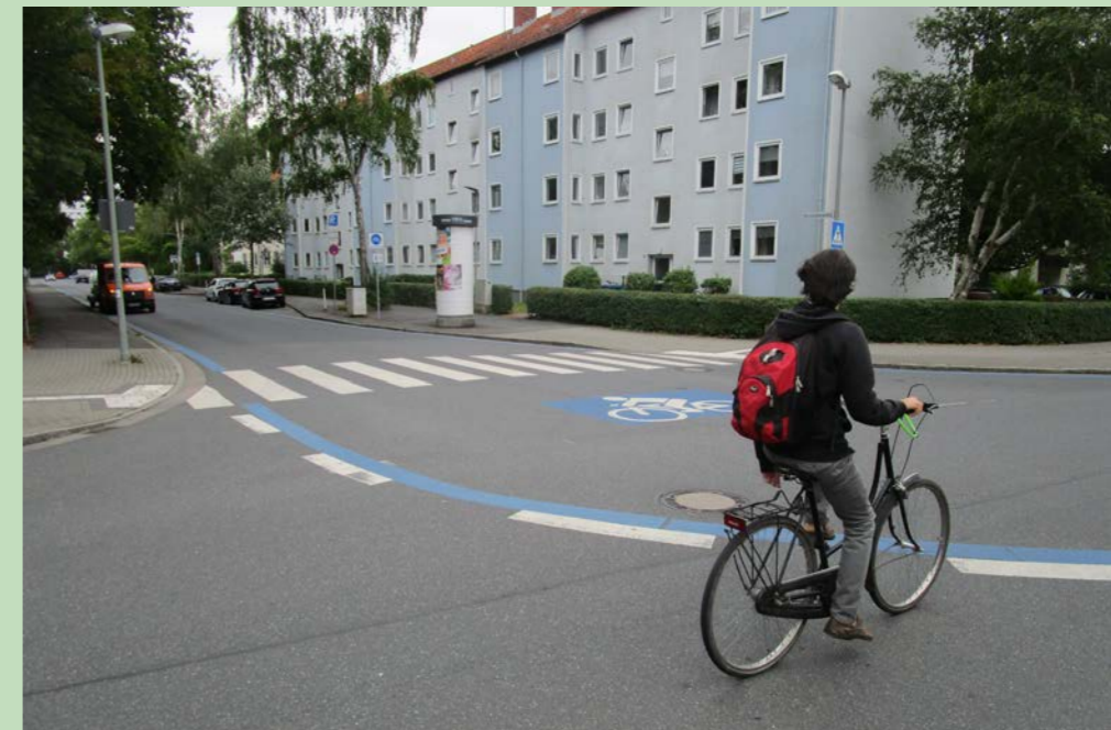
Abbildung 15: Blauer Breitstrich im Bereich des eRadschnellweges, der auch gleichzeitig die Vorfahrtstraße verdeutlicht (Christophorusweg/Goßlerstraße).
