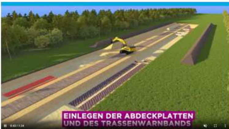
Einlegen der Abdeckplatten und des Trassenwarnbands
