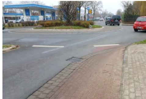
Abb. 3.6-6 Radwegeführung am Kreisverkehr, Bahnhofstraße/ Alexanderstraße
