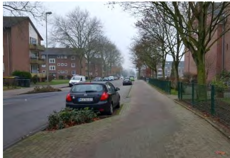
Abb. 3.5-3 Getrennter Geh- und Radweg, Spellener Straße
