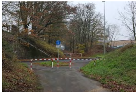
Abb. 3.6-8 Umlaufgitter mit geringem Abstand, Alte Mittelstraße/ Spellener Straße
