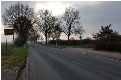
Abb. 3.6-7 Unsichere Überleitung auf die Fahrbahn, Mehrumer Straße
