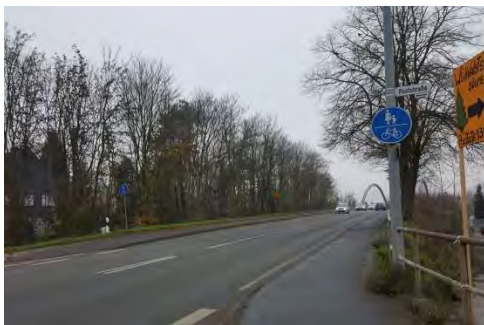
Abb. 3.5-4 Gemeinsamer Geh- und Radweg, Hindenburgstraße (B8)
