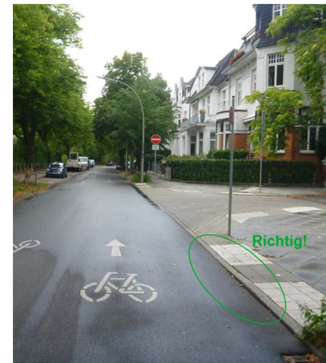
Abbildung 22: Korrekte Ausbildung einer Gehwegüberfahrt in Hamburg. Der Bordstein verläuft durchgehend parallel zur bevorrechtigten Fahrradstraße (Leinpfad/Mövenstraße).
