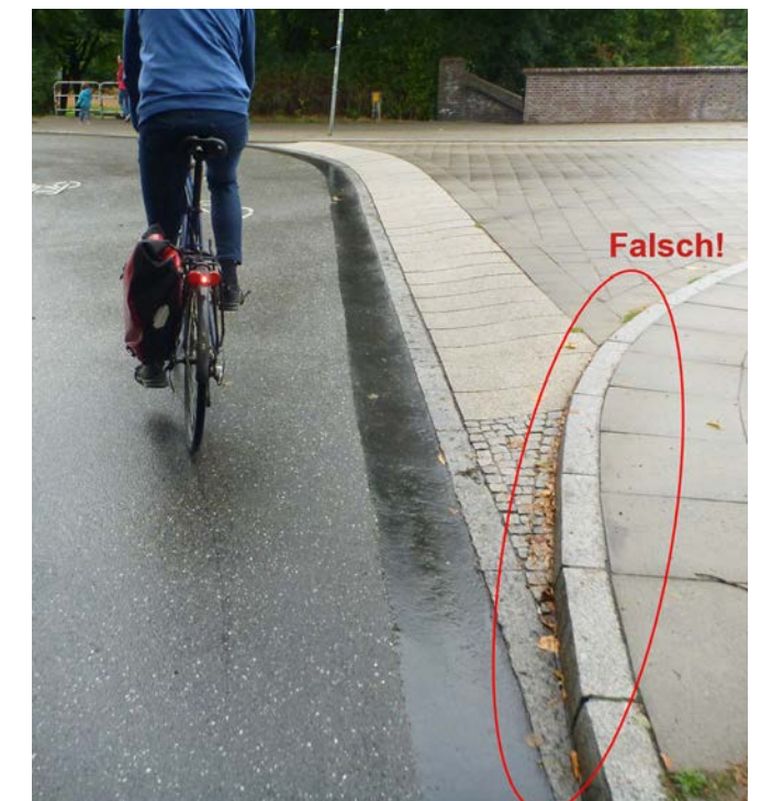
Abbildung 23: Falsche Ausbildung einer Gehwegüberfahrt, ebenfalls Hamburg. Der Bordstein folgt der einmündenden Straße (Uferstraße/Von-Essen-Straße).
