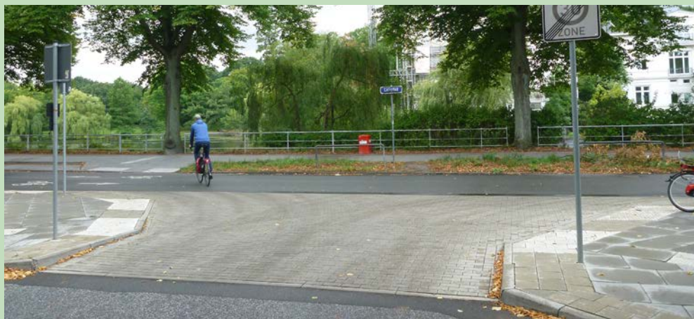
Abbildung 29: Gehwegüberfahrt am Leinpfad in Hamburg.
