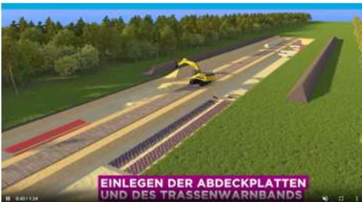
Einlegen der Abdeckplatten und des Trassenwarnbands
