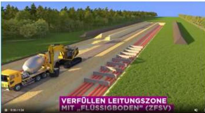
Verfüllen der Leitungszone mit Flüssigboden (ZFSV)
