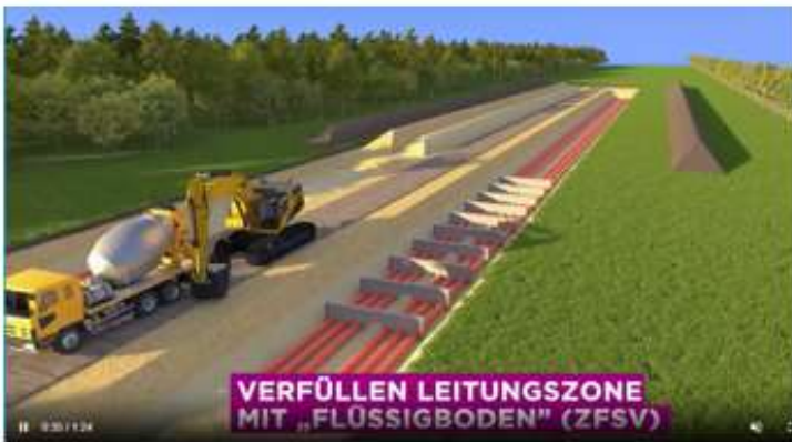
Verfüllen der Leitungszone mit Flüssigboden (ZFSV)
