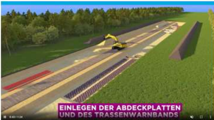
Einlegen der Abdeckplatten und des Trassenwarnbands
