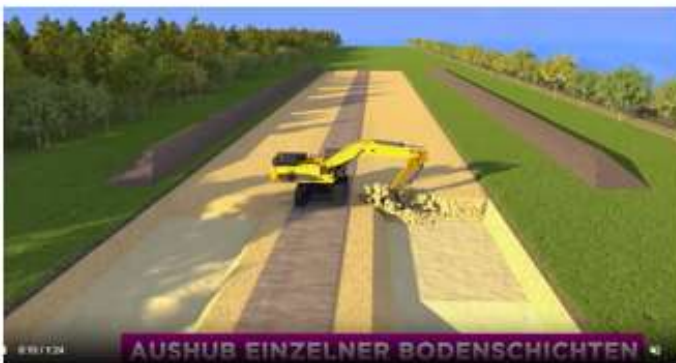
Aushub einzelner Bodenschichten
