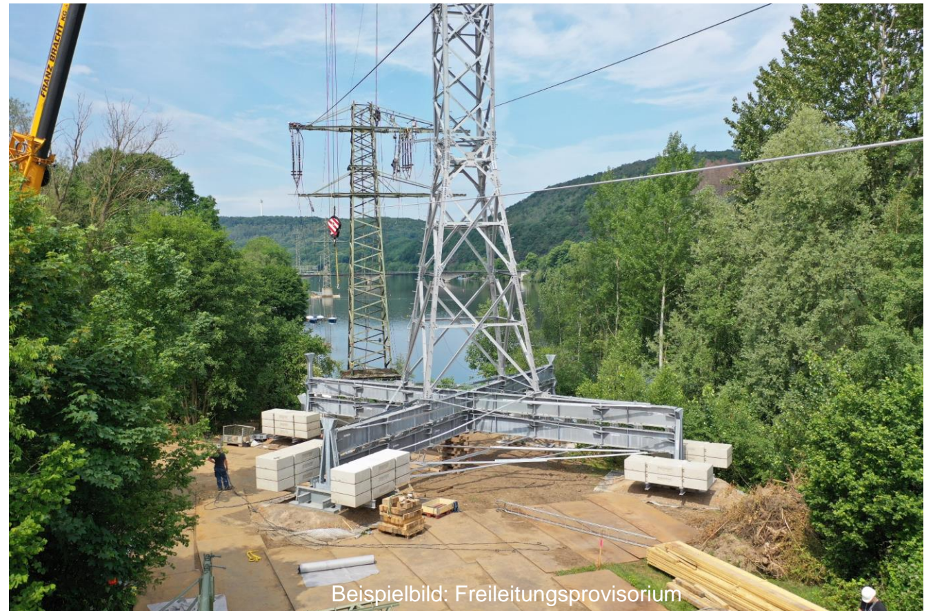
Beispielbild: Freileitungsprovisorium
