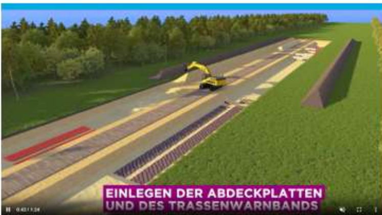
Einlegen der Abdeckplatten und des Trassenwarnbands
