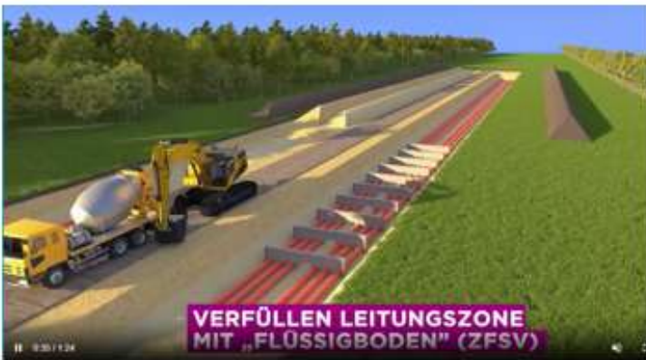
Verfüllen der Leitungszone mit Flüssigboden (ZFSV)
