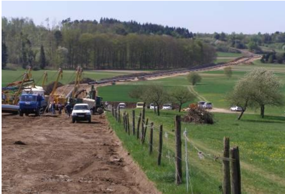
während des Leitungsbaus....
