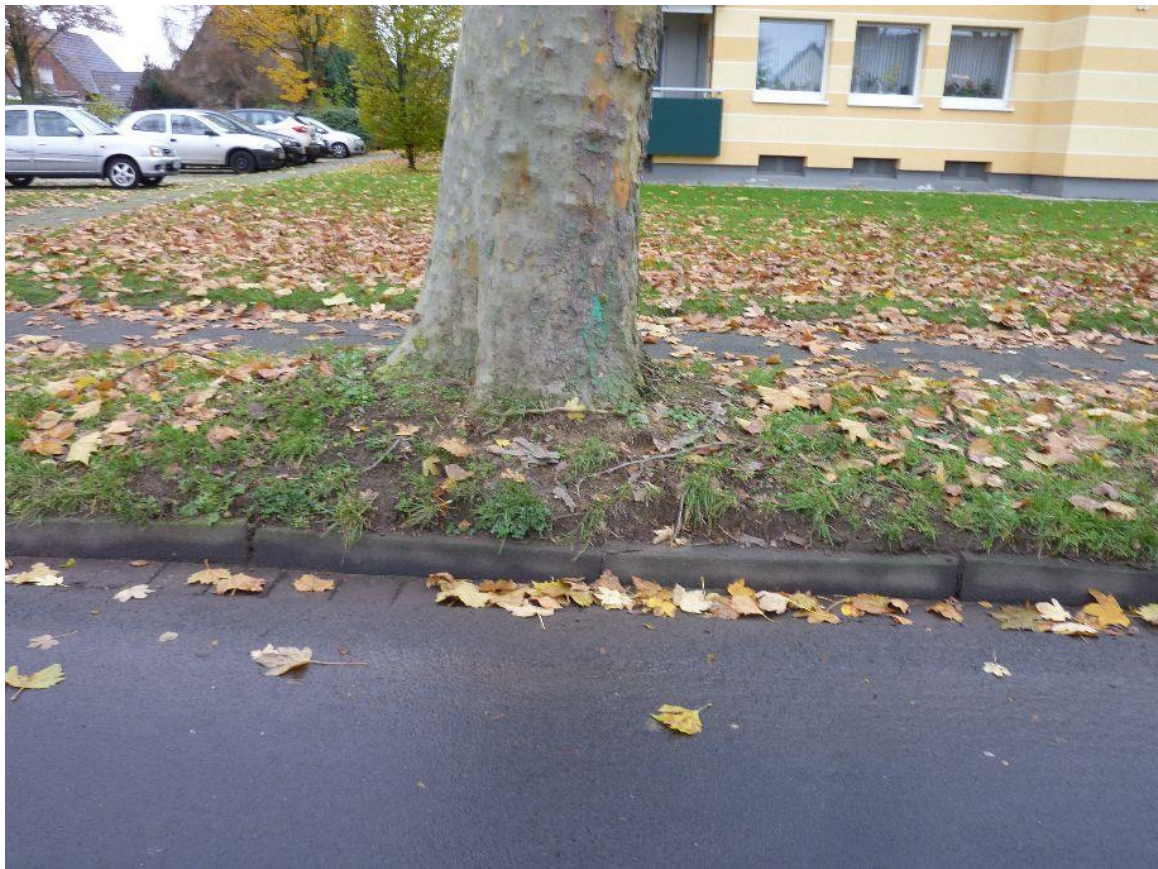
Der Stammfuß des Baumes (hier: einer Platane) ist deutlich höher als das Niveau der Straße und noch ca. 20 cm höher als die Oberkante des vorhandenen Bordsteins.
