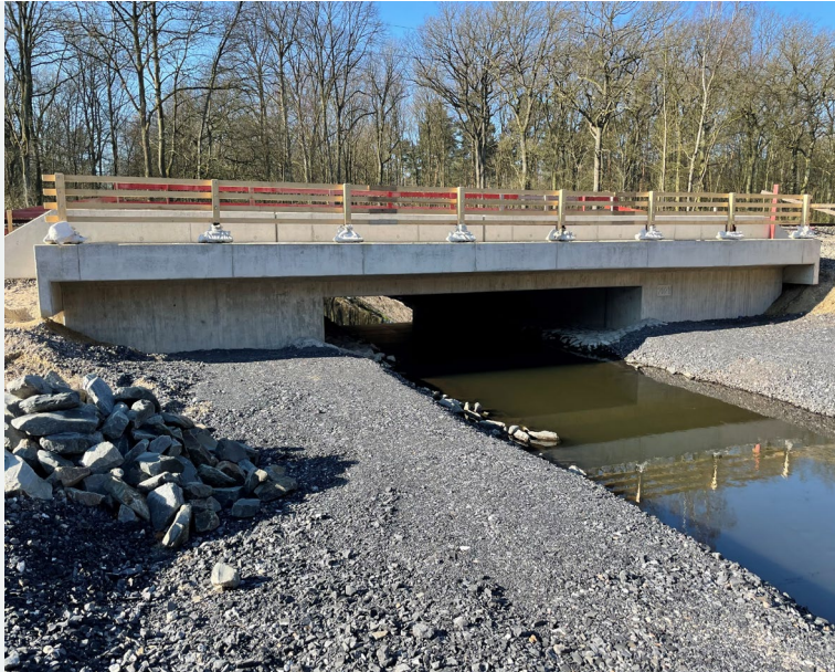
Eisenbahnüberführung Lohberger Entwässerungsgraben
