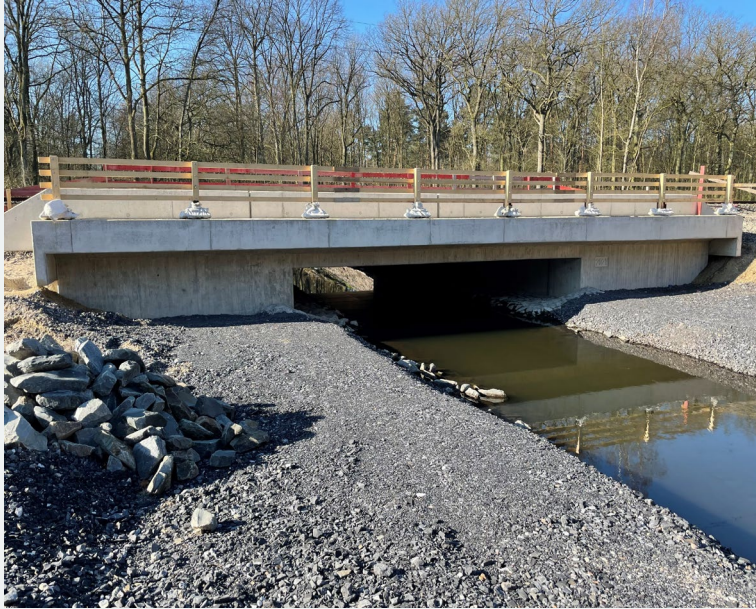
Eisenbahnüberführung Lohberger Entwässerungsgraben
