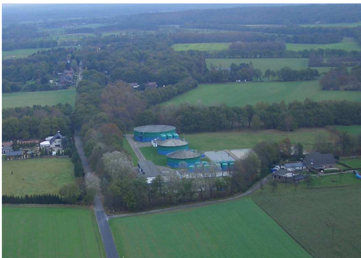
Abbildung 7: Luftbild Wasserwerk Bucholtwelmen
