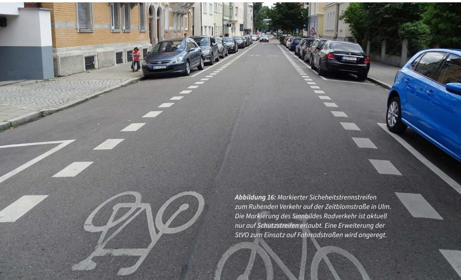
Abbildung 16: Markierter Sicherheitstrennstreifen zum Ruhenden Verkehr auf der Zeitblomstraße in Ulm. Die Markierung des Sinnbildes Radverkehr ist aktuell nur auf Schutzstreifen erlaubt. Eine Erweiterung der StVO zum Einsatz auf Fahrradstraßen wird angeregt.
