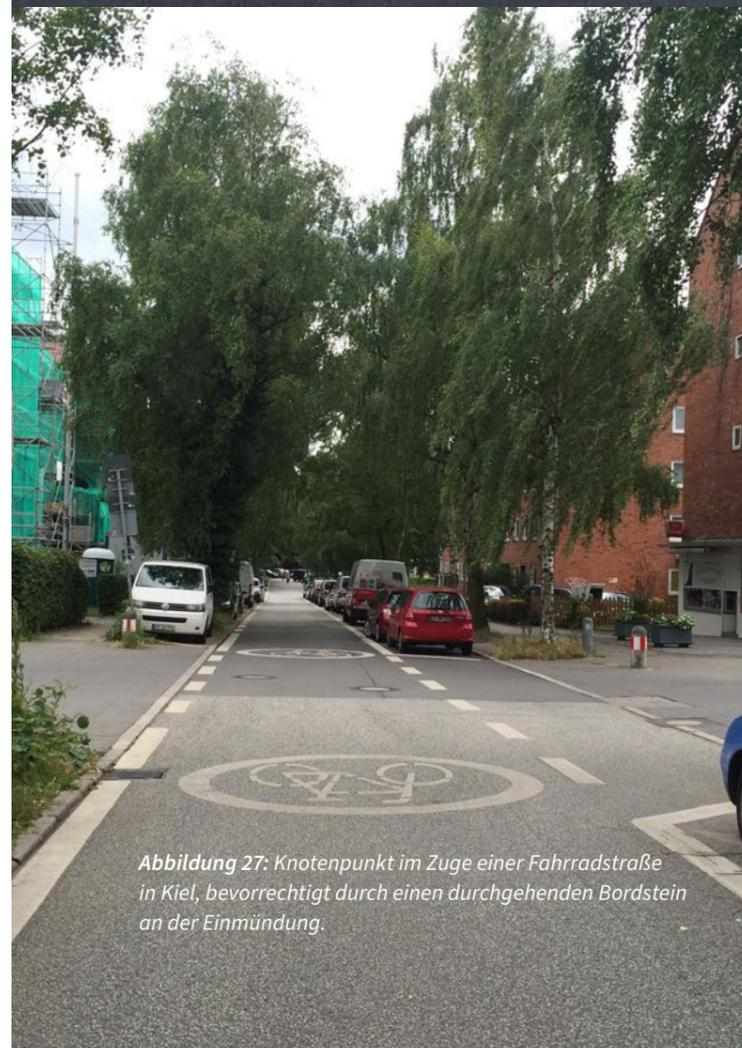
Abbildung 27: Knotenpunkt im Zuge einer Fahrradstraße in Kiel, bevorrechtigt durch einen durchgehenden Bordstein an der Einmündung.
