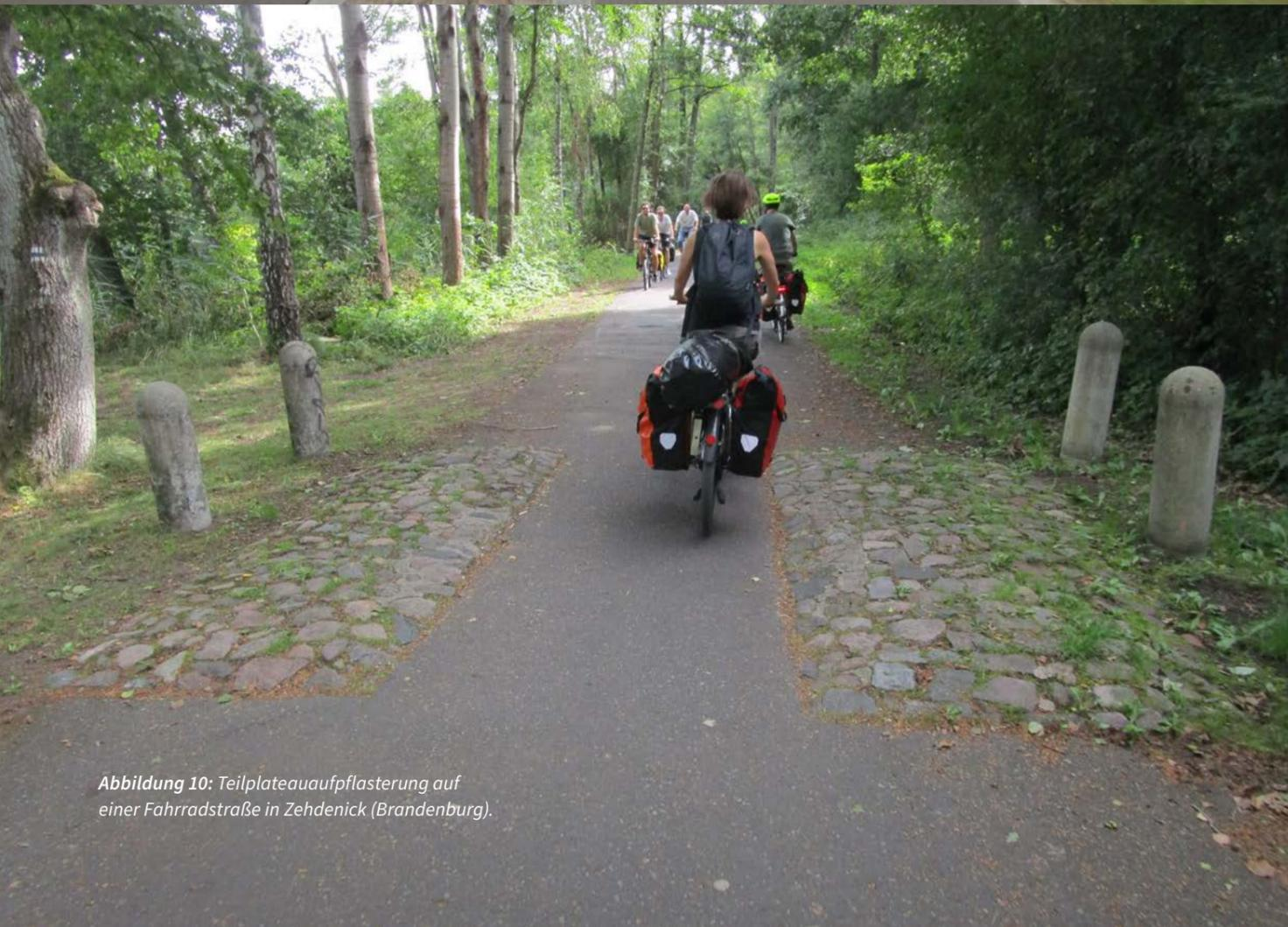
Abbildung 10: Teilplateauaufpflasterung auf einer Fahrradstraße in Zehdenick (Brandenburg).
