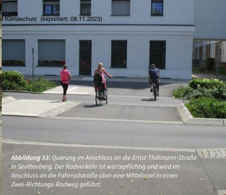
Abbildung 33: Querung im Anschluss an die Ernst-Thälmann-Straße in Senftenberg. Der Radverkehr ist wartepflichtig und wird im Anschluss an die Fahrradstraße über eine Mittelinsel in einen Zwei-Richtungs-Radweg geführt.
