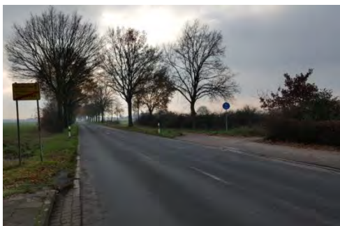
Abb. 3.6-7 Unsichere Überleitung auf die Fahrbahn, Mehrumer Straße
