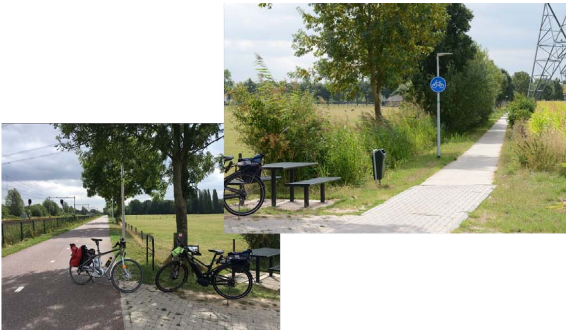
Abbildung 32: Hochwertige Ausstattung Radwege, Belag, Beleuchtung, Aufenthalt
