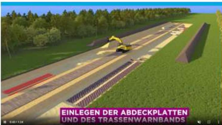
Einlegen der Abdeckplatten und des Trassenwarnbands
