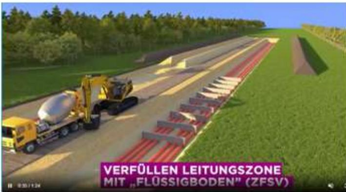
Verfüllen der Leitungszone mit Flüssigboden (ZFSV)
