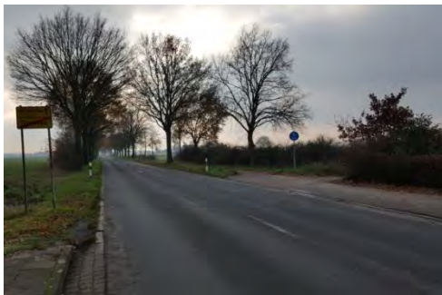
Abb. 3.6-7 Unsichere Überleitung auf die Fahrbahn, Mehrumer Straße
